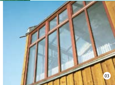
03. Die Holzverkleidung des Wintergartens strahlt auch nach außen die behagliche Atmosphäre aus, die THERMOPLUS® im Inneren spendet.
